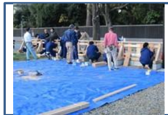
工事中(研修中)の様子
